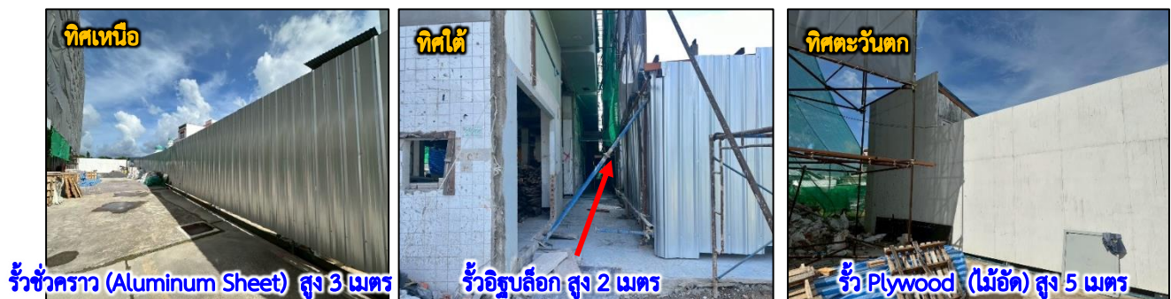
รูปที่ 4.4.3-1 รั้วอิฐบล็อก และรั้วชั่วคราว (Aluminum Sheet) บริเวณพื้นที่โครงการ
